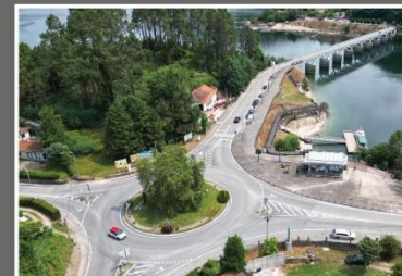
REQUALIFICAÇÃO DE PAREDES - RIO CALDO
